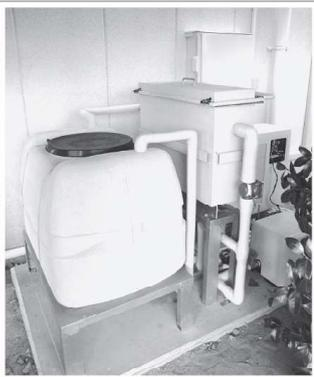
群馬電機に設置された地下水利型ヒートポンプ冷暖房システム
