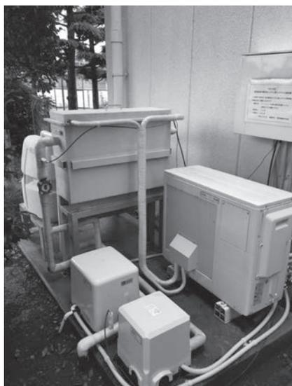
写真1 群馬電機(株)に設置された地下水利用型地中熱利用空調システム
